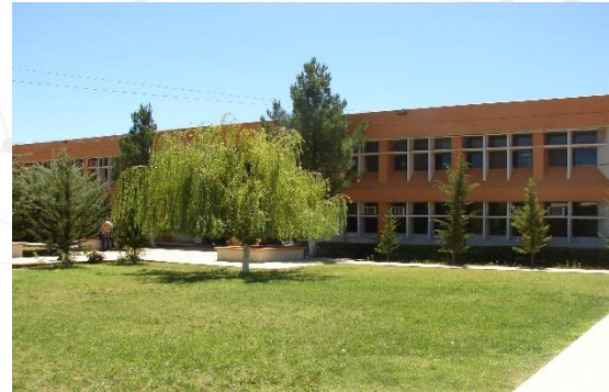
Infraestructura del Instituto Tecnológico Superior de Cananea
